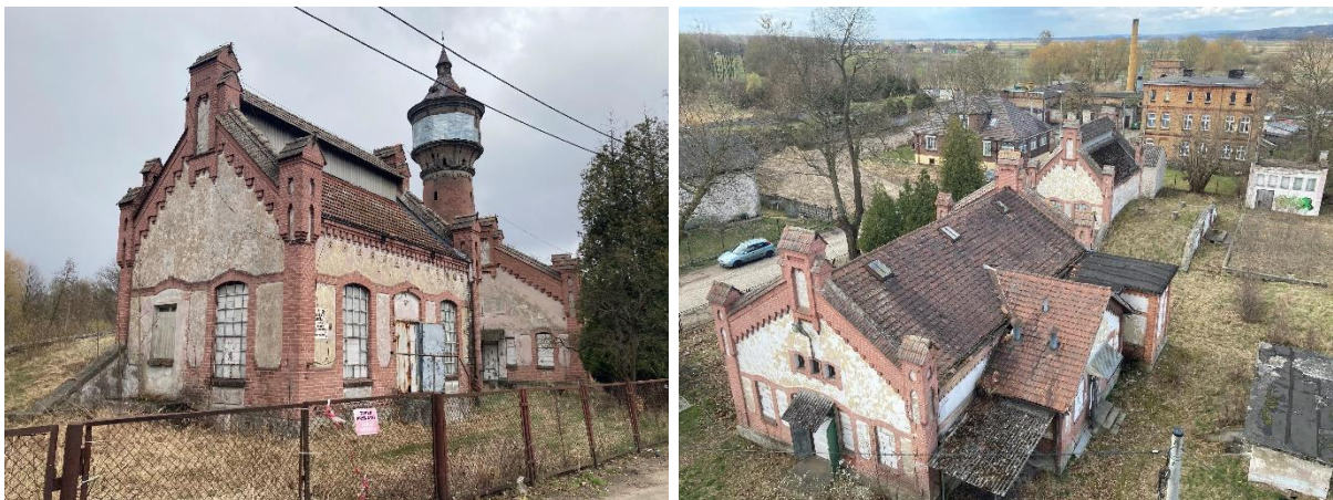
Fot. 16. Zespół dawnego miejskiego zakładu wodociągów przy ulicy Niepodległości
